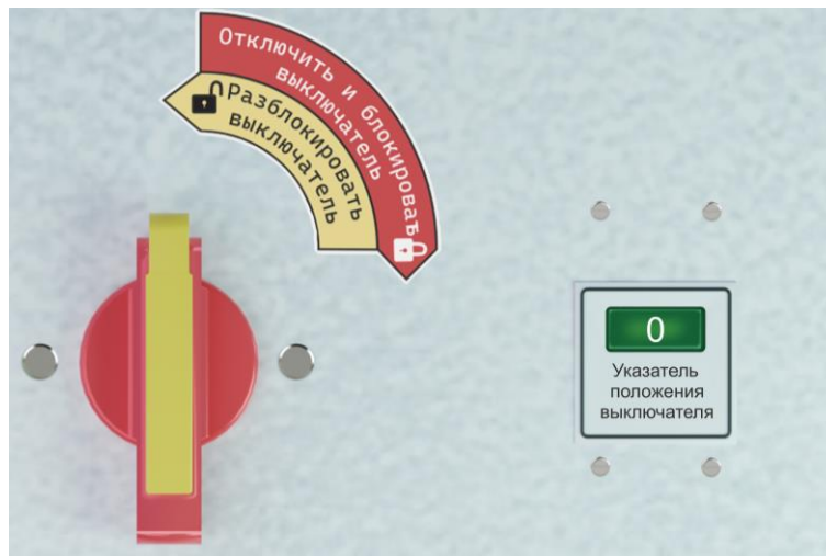
Рис. АПС. 9. Ключ блокировки СВ Байпас и указатель положения СВ Байпас
